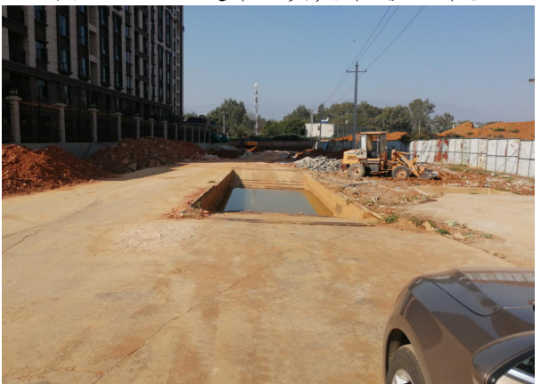
图 2.9 项目区已实施车辆清洗设施
