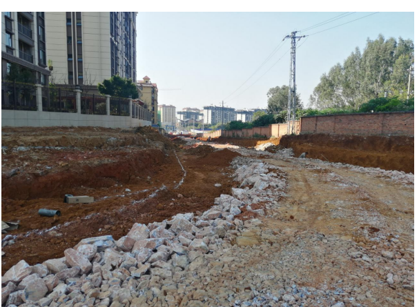
图 2.11 LS13 道路施工现状
