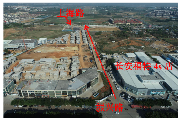
图 2.3 永善街（振兴路-上海路段）现状
