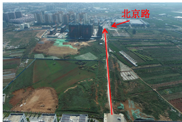
图 2.5 LS22 道路（北京路-滇南绿洲段）现状
